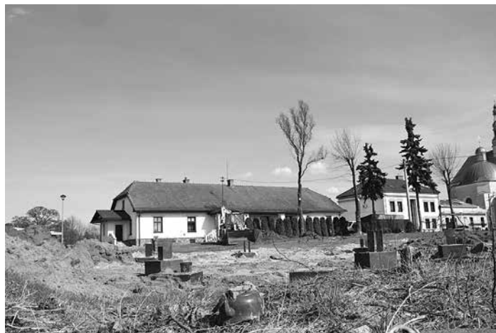
Budowa ogrodu z altaną przy Dziennym Domu Seniora
