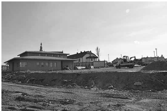
Budowa Dziennego Domu Seniora przy ul. Narutowicza
