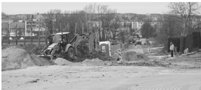
Przebudowa ul. Żytniej w Kolbuszowej
