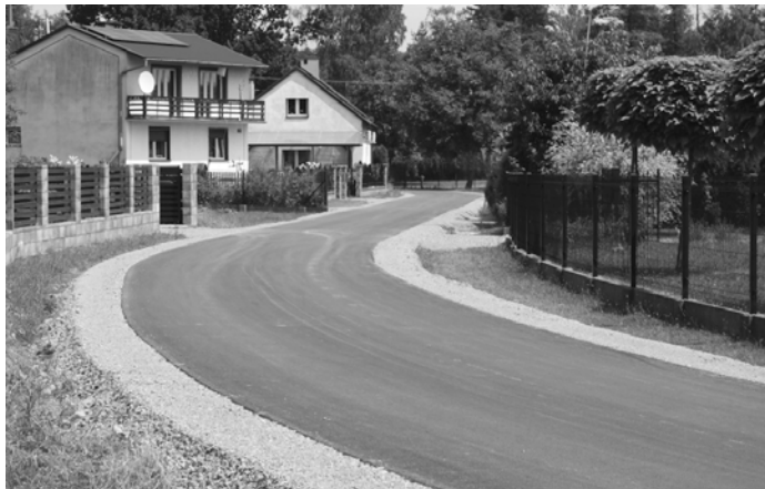
Przebudowany fragment drogi gminnej Widelka – Liszcze
