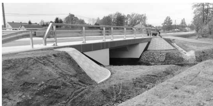
Przebudowany most w Widelce
