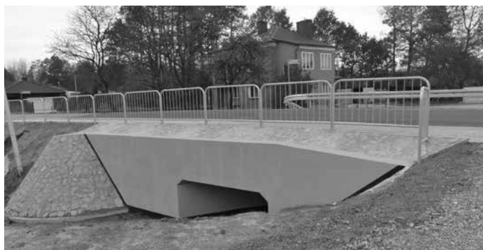
Przebudowany przepust w Widelce
