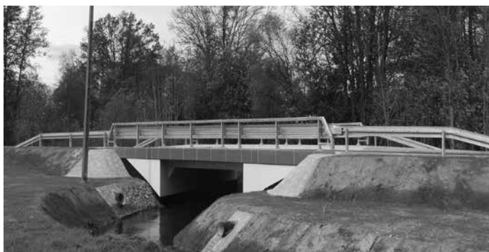
Kompleksowo zmodernizowany most w Widelce
