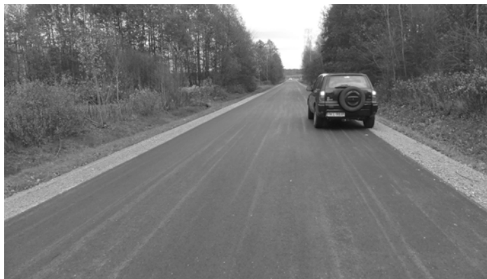
Nowy dywanik asfaltowy został położony na odcinku liczącym prawie 2,5 kilometra. Fot. B. Żarkowska
