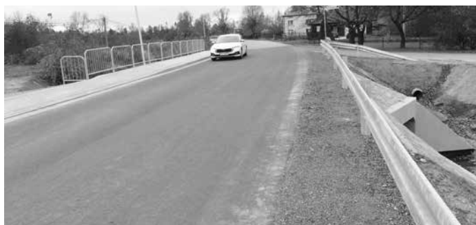
Nowo przebudowany przepust w Widelce
